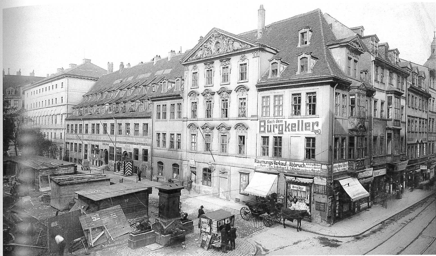
Der »Burgkellerblock« vor dem Abriß um 1907, Foto Hermann Walter
